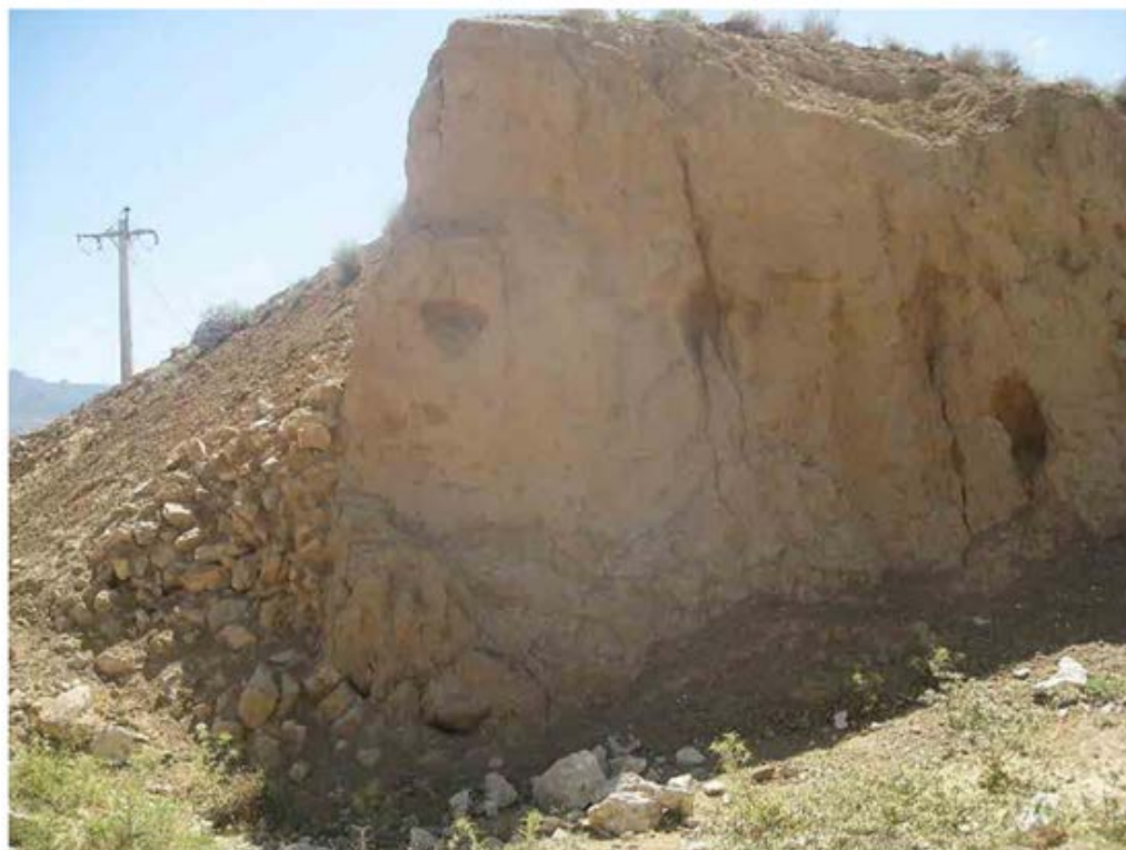
تصویر ۸: ب) هسته رسی و پوسته لاشه سنگی سد (محمدی فر و کرمی، ۱۴۰۱). Fig. 8: B) Clay Core and Stone carcass Shell of Dam (Mohammadifar & Karami, 2021).
